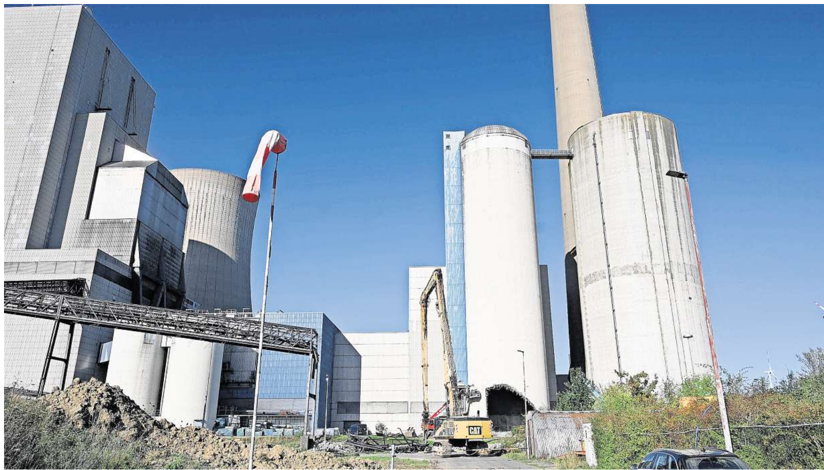
Das Kraftwerk Mehrum wird rückgebaut. Einige Teile der Anlage sollen gesprengt werden.
