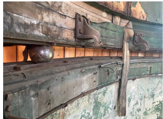
Ehemals auf 3 „Kanonenkugeln“ gelagerter Rollenkranz. Aufgrund Schiefelage wurde in den letzten Jahren 3 weitere Stahlkugeln nachgedreht und eingesetzt.
